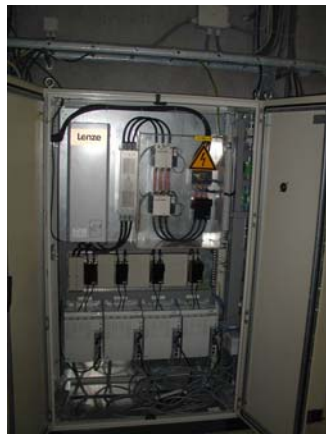
Vermogensgedeelte (met energierecuperatie tijdens het dalen)
