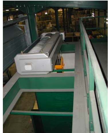
Bevestiging van de takels in de nok van het dak
